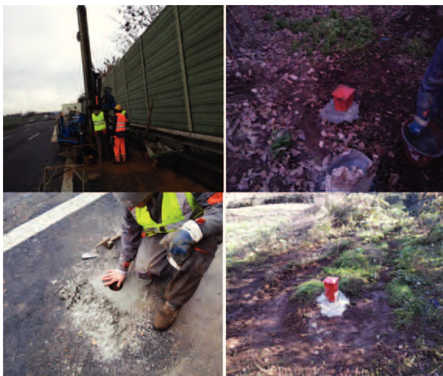
Messa in opera del tubo piezometrico in corrispondenza del M145 S03 e foto chiusino sondaggi M145 S02, M145 S03 e M145 S04
