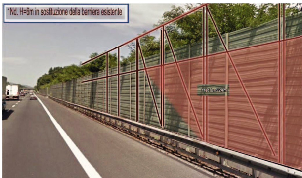
Figura 2.8 - Int. 1Nd in sostituzione della barriera antirumore esistente
